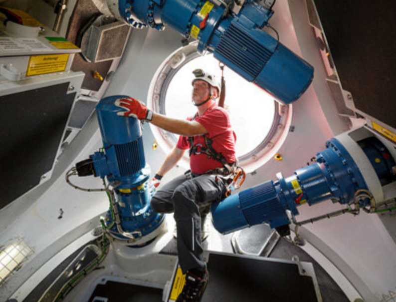
Wartung von Windkraftanlagen.
